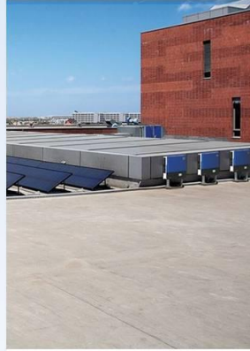
รูปที่ 4.7 ตัวอย่างการติดตั้งเครื่องแปลงกระแสไฟฟ้าแบบรวมศูนย์กลาง และแบบกระจายศูนย์
