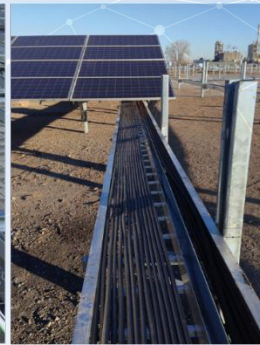
รูปที่ 5.10 ลักษณะการเดินสายไฟในรางสายไฟของระบบผลิตไฟฟ้าด้วยเซลล์แสงอาทิตย์ (ที่มาของรูป : http://solarprofessional.com )
