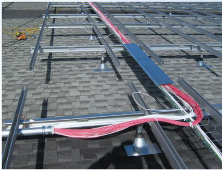
รูปที่ 5.10 ลักษณะการเดินสายไฟในรางสายไฟของระบบผลิตไฟฟ้าด้วยเซลล์แสงอาทิตย์ (ที่มาของรูป : http://solarprofessional.com )
