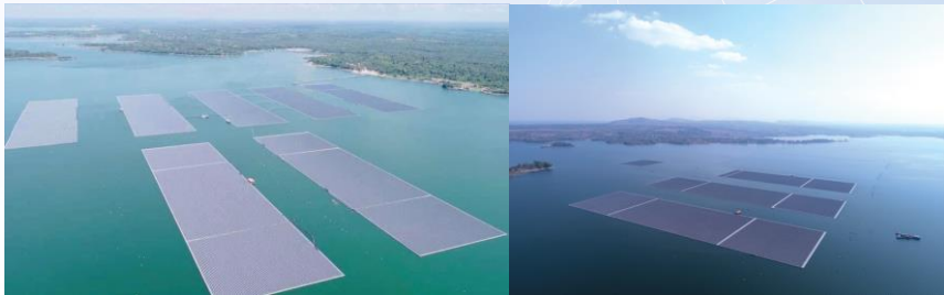
รูปที่ 1.15 ระบบผลิตไฟฟ้าเซลล์แสงอาทิตย์บนทุ่นลอยร่วมกับโรงไฟฟ้าพลังน้ำ 45 เมกะวัตต์ (AC) ที่เขื่อนสิรินธร จ.อุบลราชธานี
