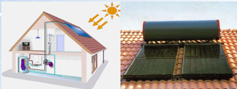
รูปที่ 2.8 การติดตั้งแผงเครื่องทำน้ำร้อนด้วยแสงอาทิตย์ในบ้านพักอาศัย
