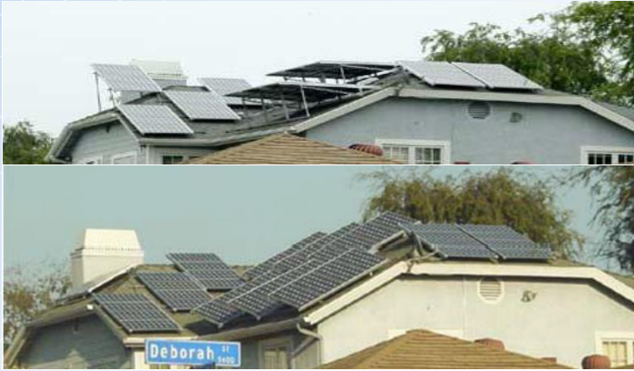
รูปที่ 5.5 ตัวอย่างการติดตั้งแผงเซลล์แสงอาทิตย์โดยไม่คำนึงถึงทิศทางของดวงอาทิตย์ (รูปบน) และการติดตั้งโดยคำนึงถึงทิศทางของดวงอาทิตย์ (รูปล่าง)
