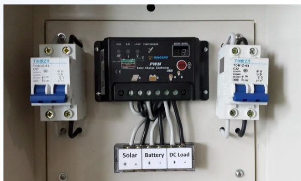
รูปที่ 5.8 ตัวอย่างการติดตั้งอุปกรณ์ทางไฟฟ้าและเบรกเกอร์ในตู้ไฟฟ้า
